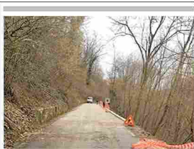
DANNEGGIATA DALL'ALLUVIONE NEL 2014
